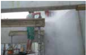
TRAVAUX DU BÂTIMENT : ponçage de béton, piquage, rainurage
