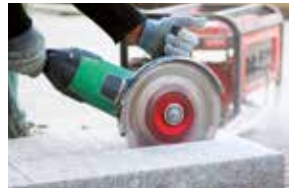
TRAVAUX PUBLICS : sciage de bordure de route
